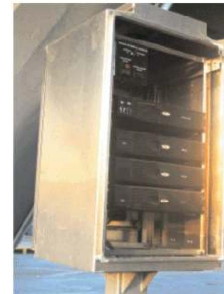
Nuestros excelentes equipos para Respaldo de Energía, proveen un almacenamiento de energía confiable basado en baterías NI/CD de trabajo pesado, brindando una excelente solución para mantener la seguridad en intersecciones de tráfico intenso o de operaciones riesgosas, y usos como:
